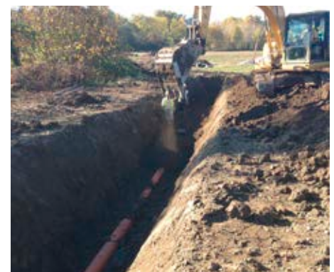
Figura 12 – Empreitada de Execução dos Intercetores do Subsistema do Sousa I - Parte II – FD 15 (nov/2013)
