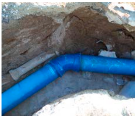
Figura 14 – Substituição da Conduta Adutora de AA entre os Cruzamentos da EM 700 e da EM 565 – Amarante (nov/ 2013)
