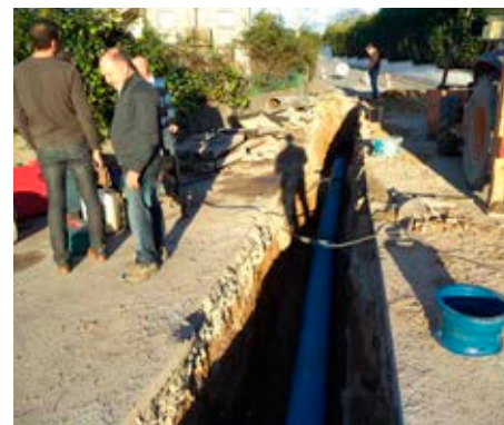
Figura 15 – Substituição da Conduta Adutora de AA entre os Cruzamentos da EM 700 e da EM 565 – Amarante (nov/ 2013)
