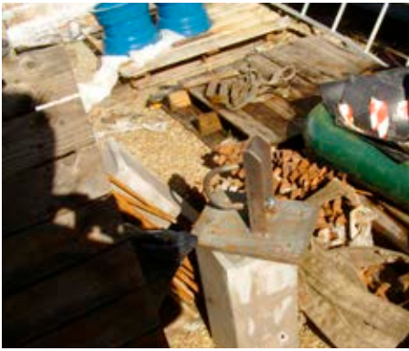
Figura 1 – Empreitada de Ligação de Rabagão ao Sistema de Queimadela – Reservatório de Aboim RL02 e Travessias de Linhas de Água (fev/2013)
