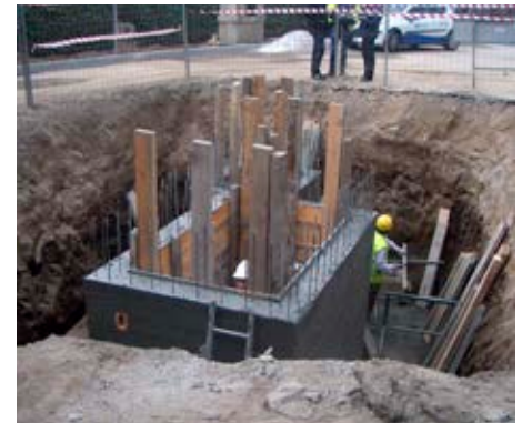
Figura 6 – Empreitada de Execução das Derivações do SAA de S. Jorge aos res. RI (Ponte da Barca) e Areosa (Viana do Castelo) (dez/2013)
