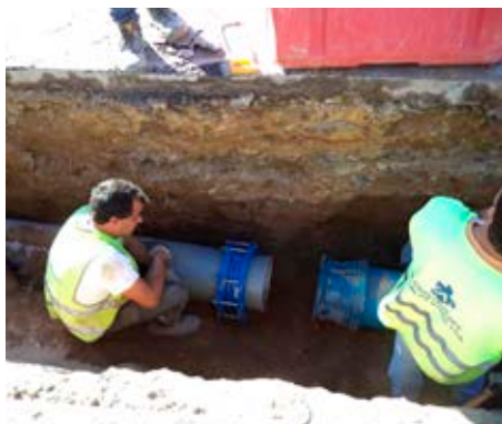
Figura 13 – Substituição da Conduta Adutora de AA entre os Cruzamentos da EM 700 e da EM 565 – Amarante (nov/ 2013)
