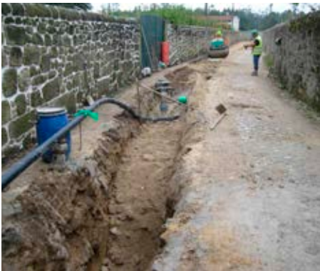
Figura 4 – Empreitada de Execução da ligação ao hospital do senhor do Bonfim em Vila do Conde (mai/2013)
