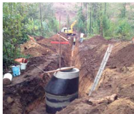
Figura 11 – Empreitada de Execução dos Intercetores do Subsistema do Sousa II - Parte II – FD 15 (set/2013)
