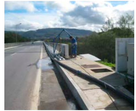
Figura 3 – Empreitada de Instalação de Apoios Deslizantes no Encontro Norte da Ponte de Lanheses (mar/2013)
