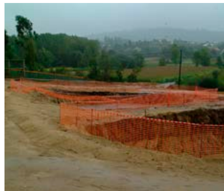
Figura 8 – Empreitada de Execução da ETAR do Neiva (set/2013)
