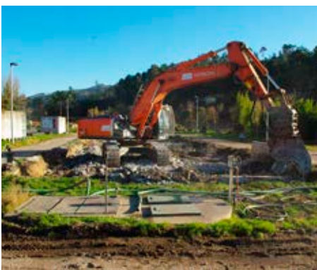
Figura 10 – Empreitada de Execução da ETAR de Vila Meã (dez/2013)
