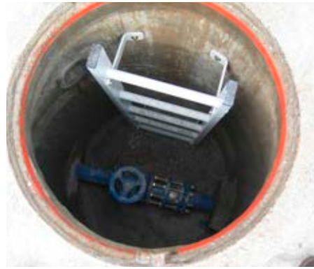
Figura 2 – Empreitada de Execução das Ligações do Reservatório de Âncora aos Reservatórios de Âncora ZA e Âncora ZB (mar/2013)
