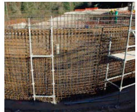
Figura 9 – Empreitada de Execução da ETAR de Ovelha (dez/2013)
