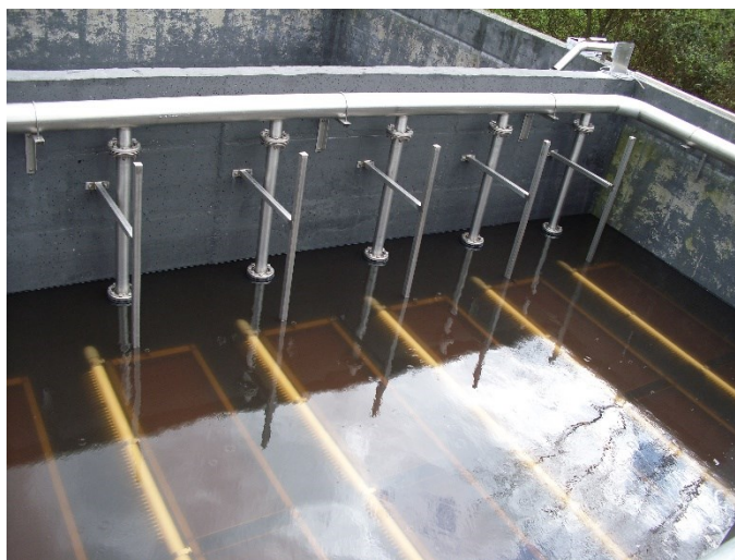
Tanque MBR com água limpa
