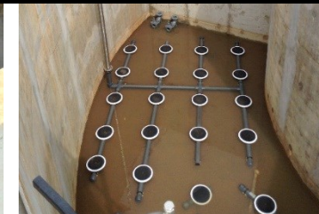
sistema de arejamento por difusores de borbulha fina
