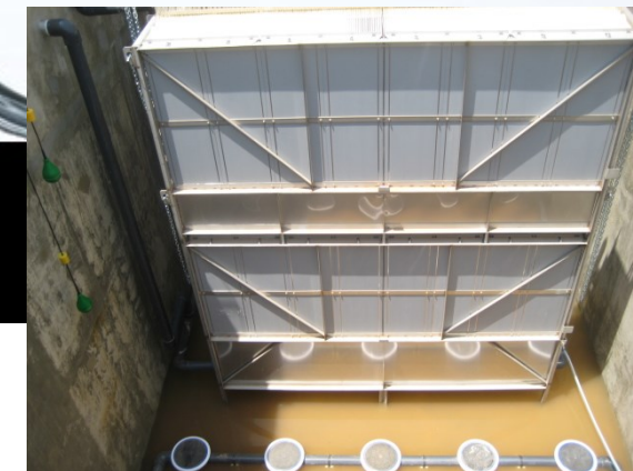
Membranas de Microfiltração do MBR e sistema de arejamento por velas porosas
