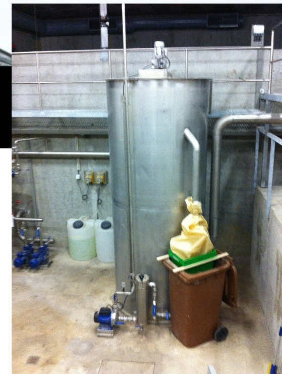
Sistema de flotação
