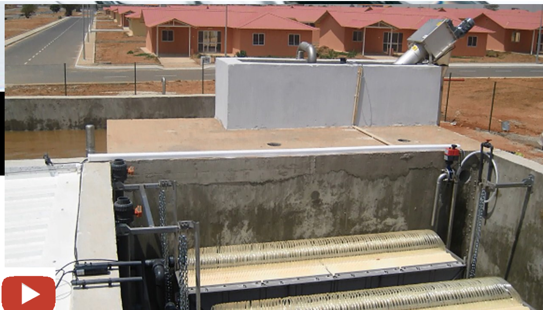
Membranas de Microfiltração do MBR e sistema de arejamento por velas porosas
