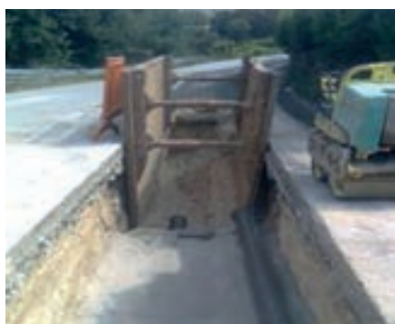
Figura 13 EB 2263 - Empreitada de Execução de Redes de Abastecimento e Saneamento na E.N. 101 (Amarante) (agosto/2014)
