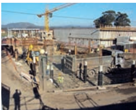
Figura 5 Empreitada de Execução da ETAR de Esposende (dez/2014)
