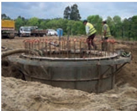
Figura 2 Reforço do Sistema de Abastecimento de Água de Paredes de Coura – Captação no Rio Coura em Freande (abr/2014)
