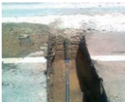
Figura 16 EB 2278 - Empreitada de execução de redes de abastecimento e saneamento na E.N. 15 (Amarante) (junho/2014)
