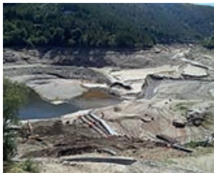
Figura 3 Empreitada de Execução da Captação de Emergência do Rabagão (jul/2014)
