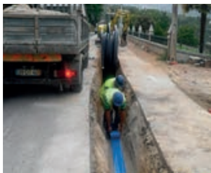
Figura 17 EB 2297 - Redes de Água e de Saneamento na EN 222 e EM 1019 (Cinfães) - Sistema de Águas da Região do Noroeste (setembro./2014)
