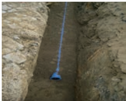
Figura 1 Execução da Conduta Adutora ao Reservatório de Vilarinho (fev/2014)
