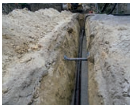
Figura 6 Empreitada de Execução do Sistema Elevatório do Rio Ave (FD 10) - 1ª Fase (out/2014)
